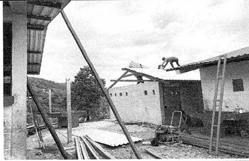
Foto 4: sustitucion e instalacion de estructura de soporte de metal y cubierta de lamina.
