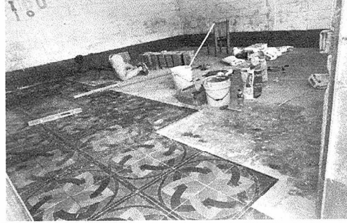
Foto 2: susticion de pisode piso ceramico en modulo de las aulas 95 m2.
