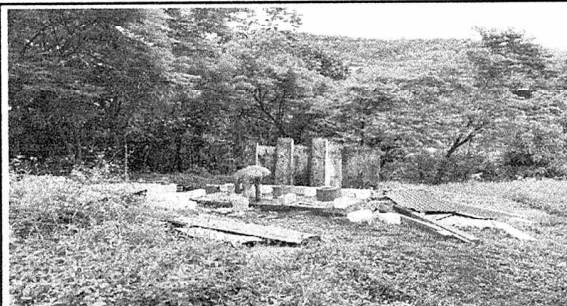
Foto 5: Sustitucion de paredes de sanitarios.
